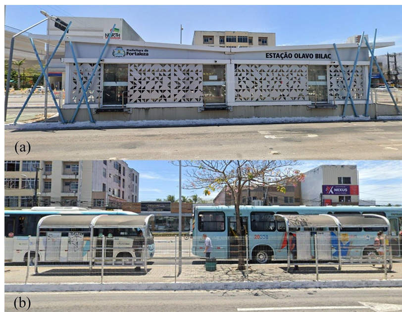
Figura 3 • (a) Estação do BRT e (b) Parada convencional.
